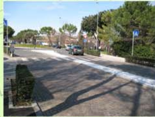
Esempio di attraversamento pedonale
