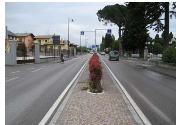
Esempio di fluidificazione/moderazione
