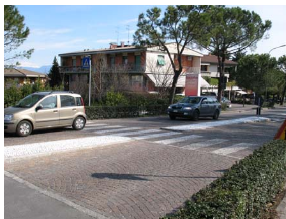
Esempio di attraversamento pedonale rialzato
