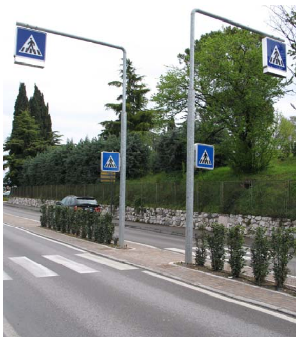
esempio di attraversamento pedonale protetto
