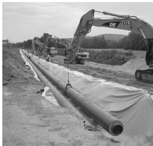
Fig. 4.19 Conduites de chauffage à distance installées dans le fossé [51].
