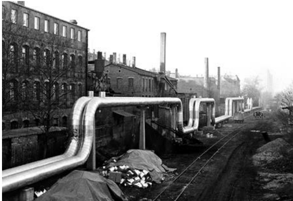
Fig. 1.1 Chauffage à distance, Leipzig (RDA), 1986 [4].
